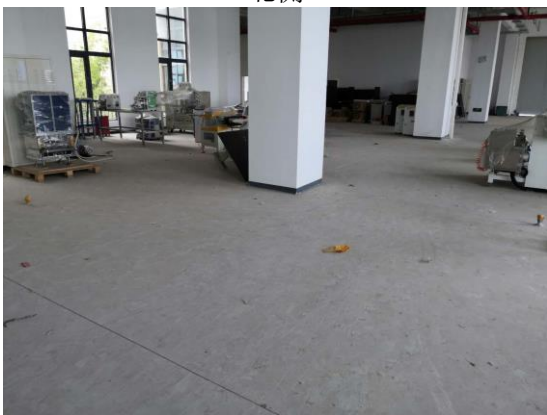
项目房屋现状
