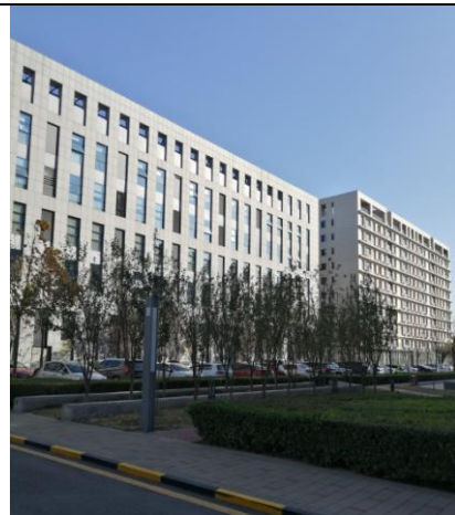
项目北侧 6 号楼
