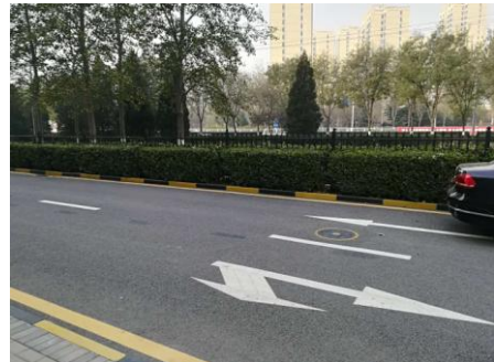
项目西侧厂区道路
