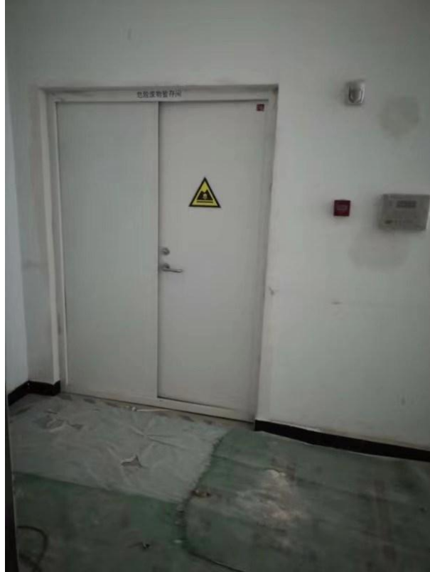
图 3-7 项目危险废物暂存间实景图
