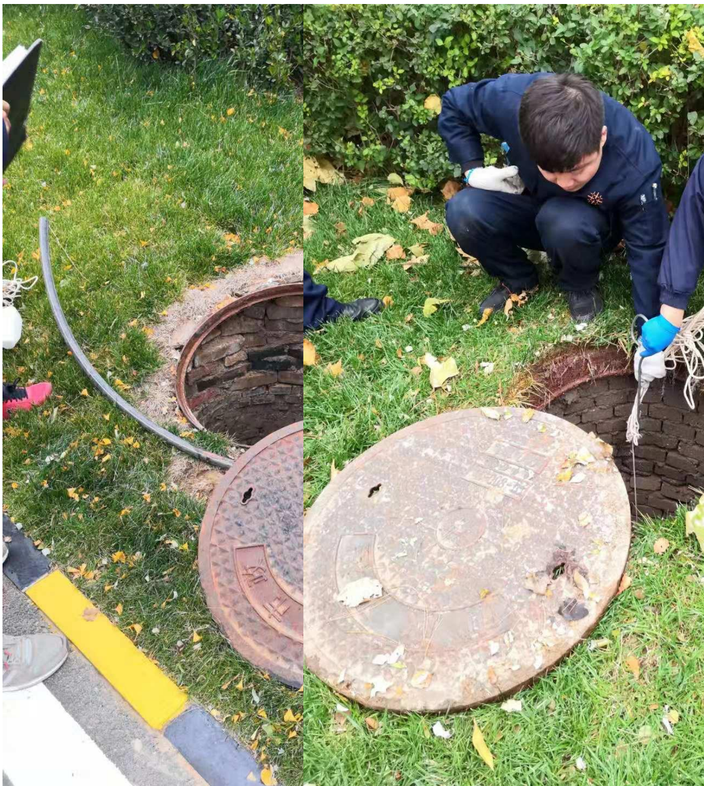
图 4-3 现状化粪池及市政总排口照片
