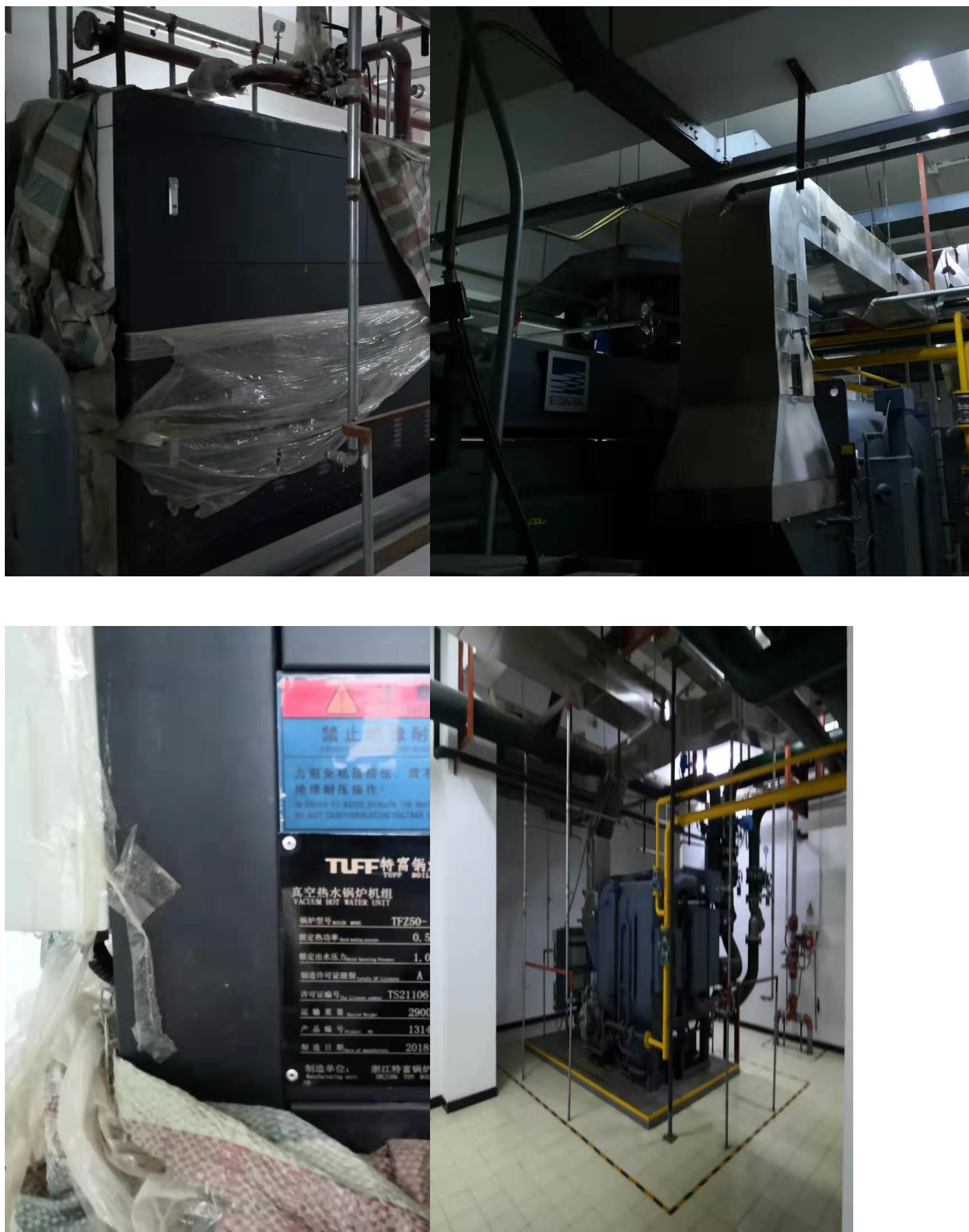
图 4-1 地下锅炉房、直燃机房
