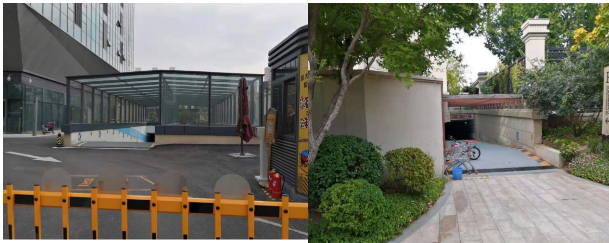
图 4-2 项目地下车库出入口和排风口
