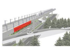
利用立交桥、铁路桥等桥梁设置
