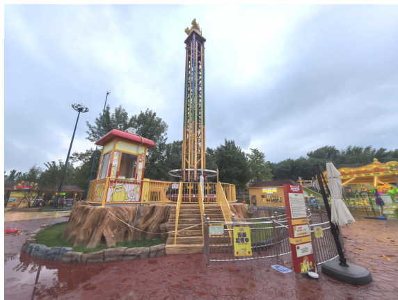
图 1 事发设备现场情况
