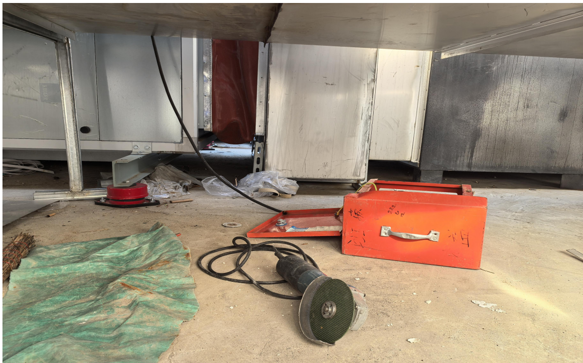
图 3 配电箱角磨机图示
