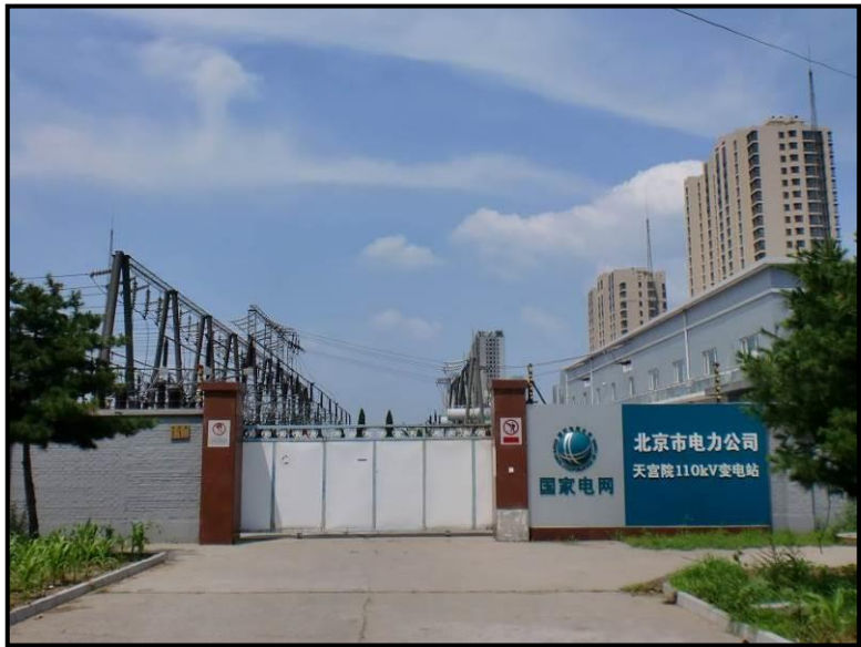
图 3.4-5 天宫院 110kV 变电站现状照片
