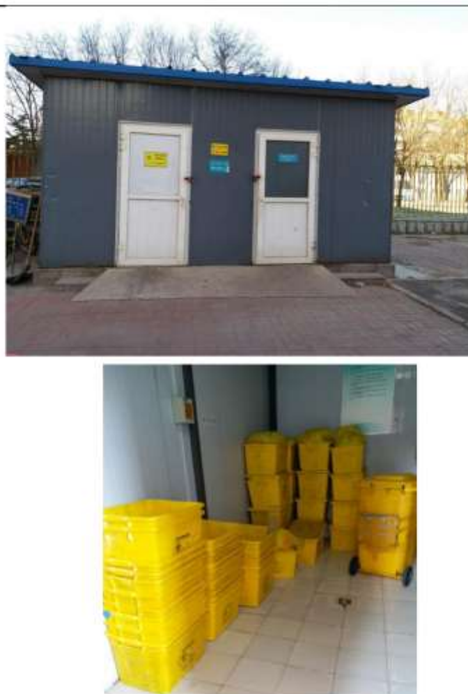
图 9-1 固体废物贮存设施
