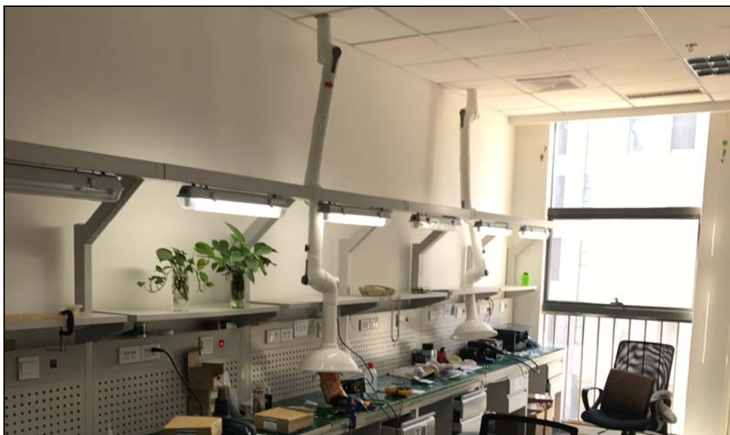
焊接工位及焊接烟尘集气罩现状图
