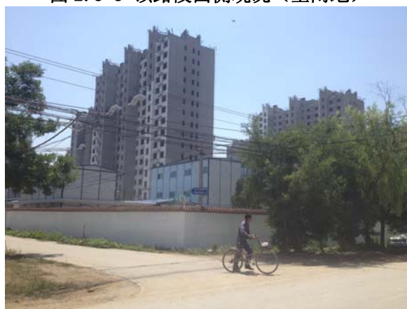
图 2.5-9 该路段东侧现状（建筑工地）
