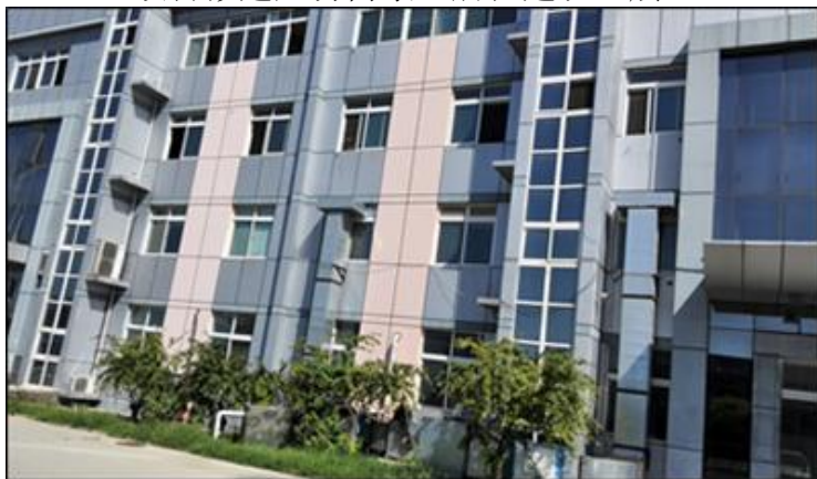
项目拟建厂房外景
