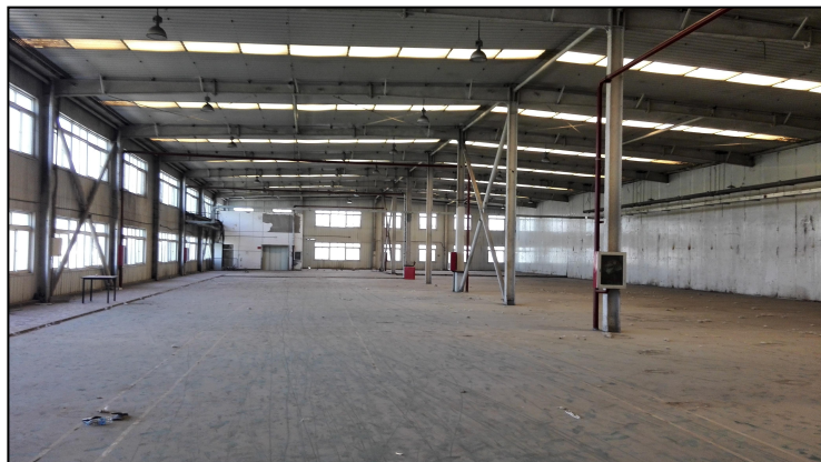
项目拟建厂房内景（所在建筑二层）
