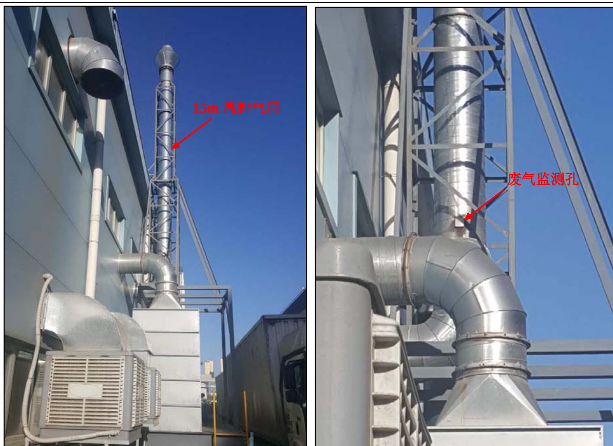
图 4 现状 15m 高排气筒照片
