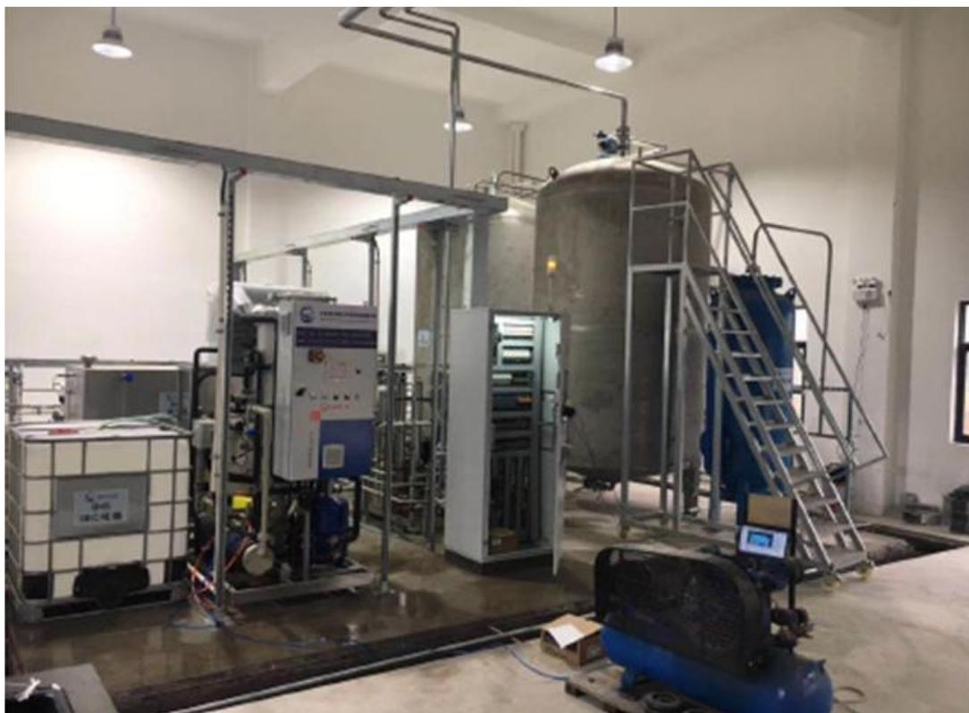
图 13 低压蒸馏设备
