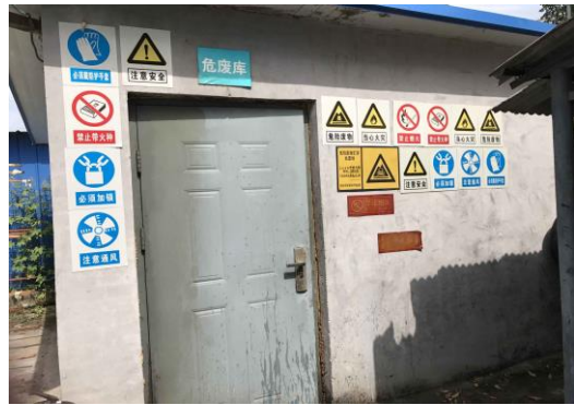
危险废物暂存间
