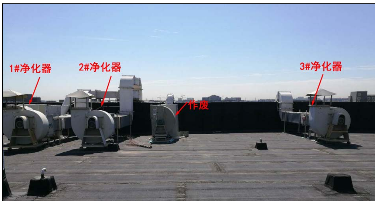
图 6-2 项目所在建筑物五层楼顶净化器现状照片
