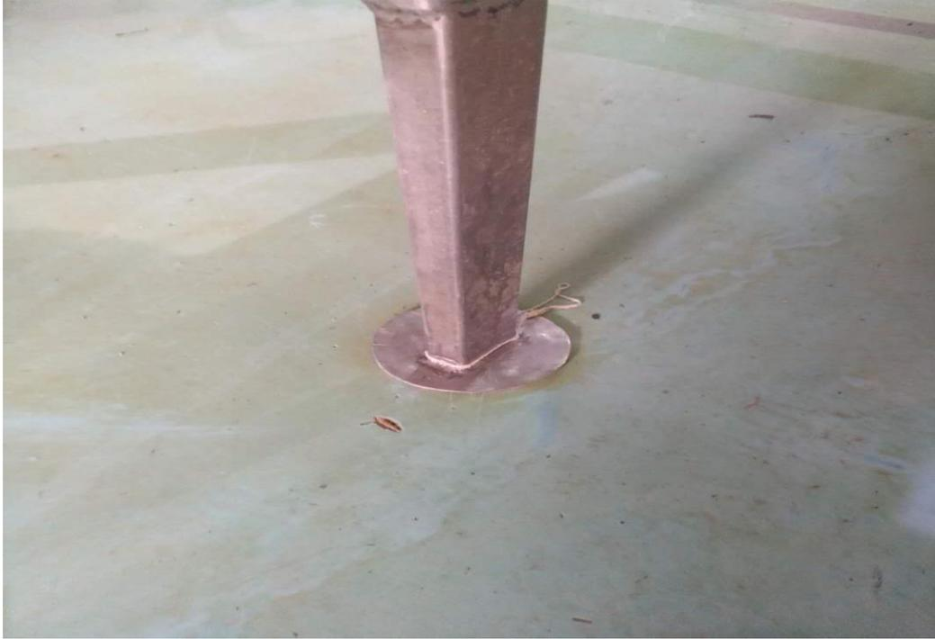
图 7 设备减震基垫
