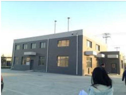
锅炉房及排气筒
