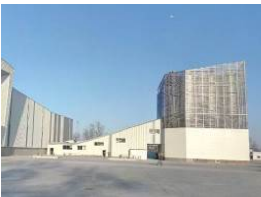
混凝土拌合站
