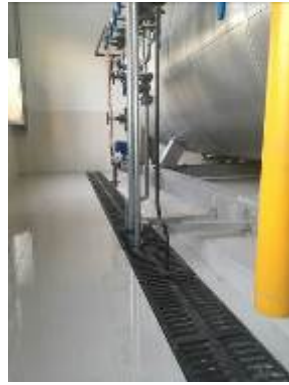
锅炉房内排水沟
