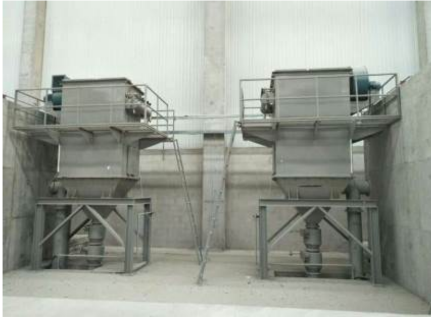
图 4.1-6 混凝土拌合站地仓负压除尘
