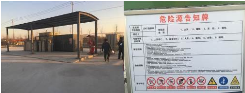
LNG 天然气站现场照片
