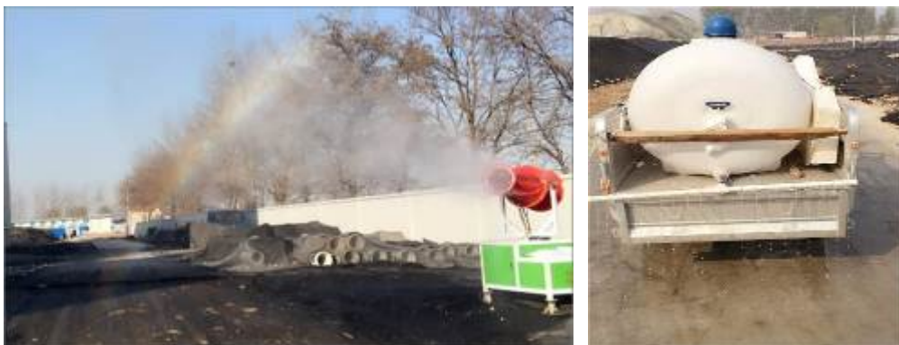
图 4.2-4 施工期环保措施现状照片
