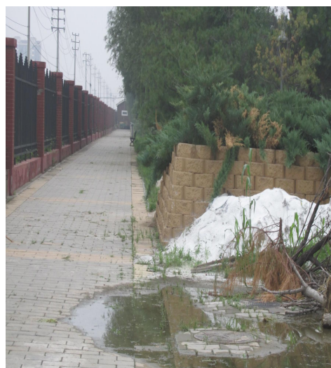
繁华路段地面平整
