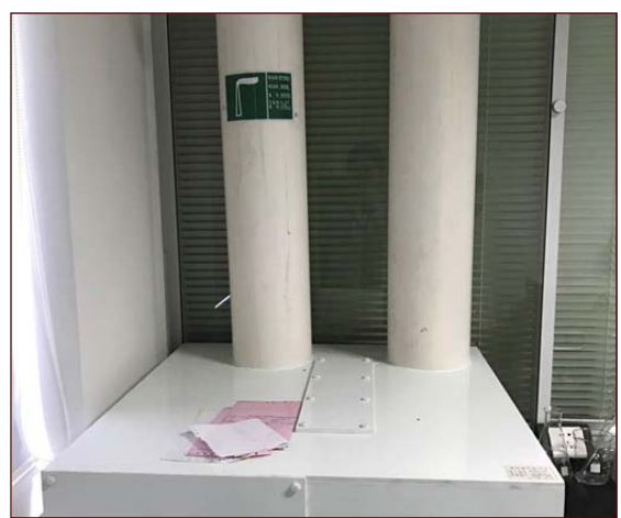
图 1-2 原项目细胞遗传实验室废气排放口现状照片
