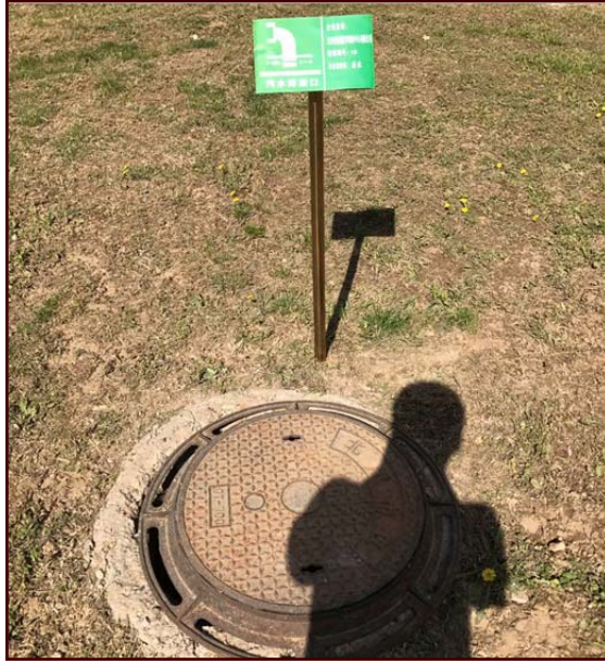
图 1-4 废水排放口现状照片
